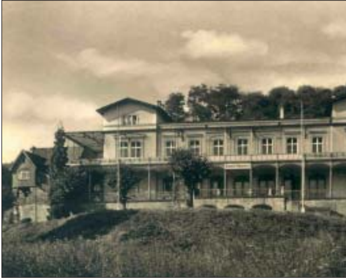
Vor 150 Jahren war hier noch die Endstation
